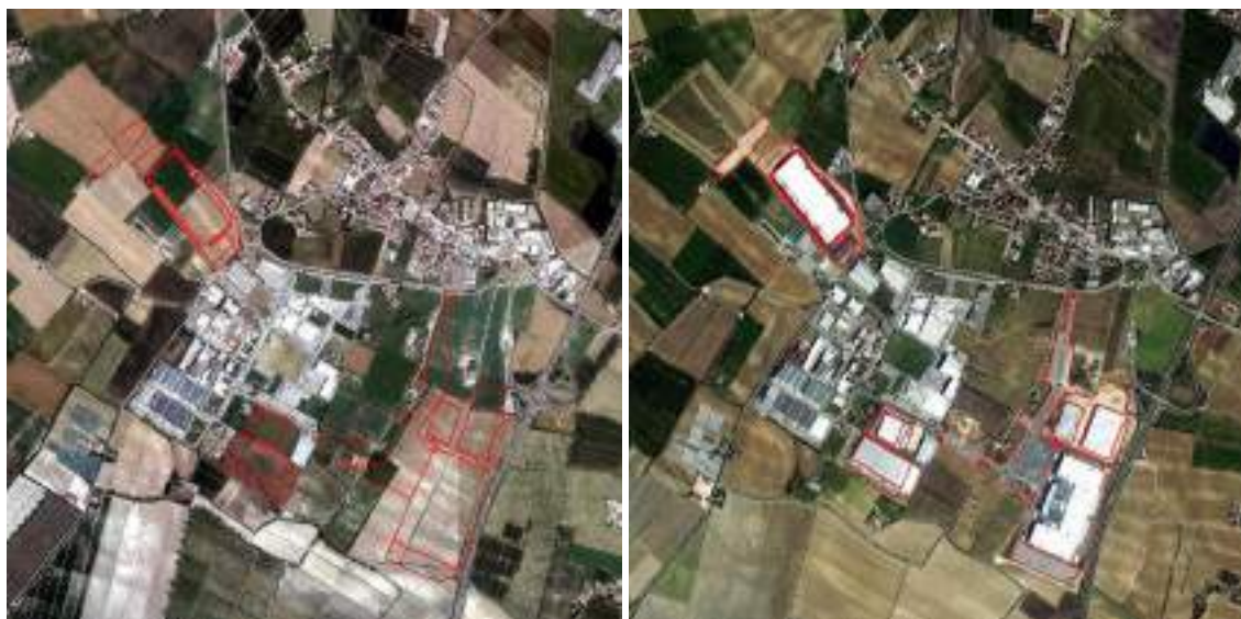
Figura 248. Il più grande polo logistico del Veneto a Nogarole Rocca (VR) realizzato interamente su terreno agricolo, con 57,6 ha impermeabilizzati tra il 2017 e il 2021, di cui 31,5 di edifici (immagine 2015 a sinistra e 2021 a destra); in basso a destra il più grande centro di e-commerce, di un marchio tedesco, con 15 ha di magazzino e una superficie impermeabilizzata totale pari al doppio
