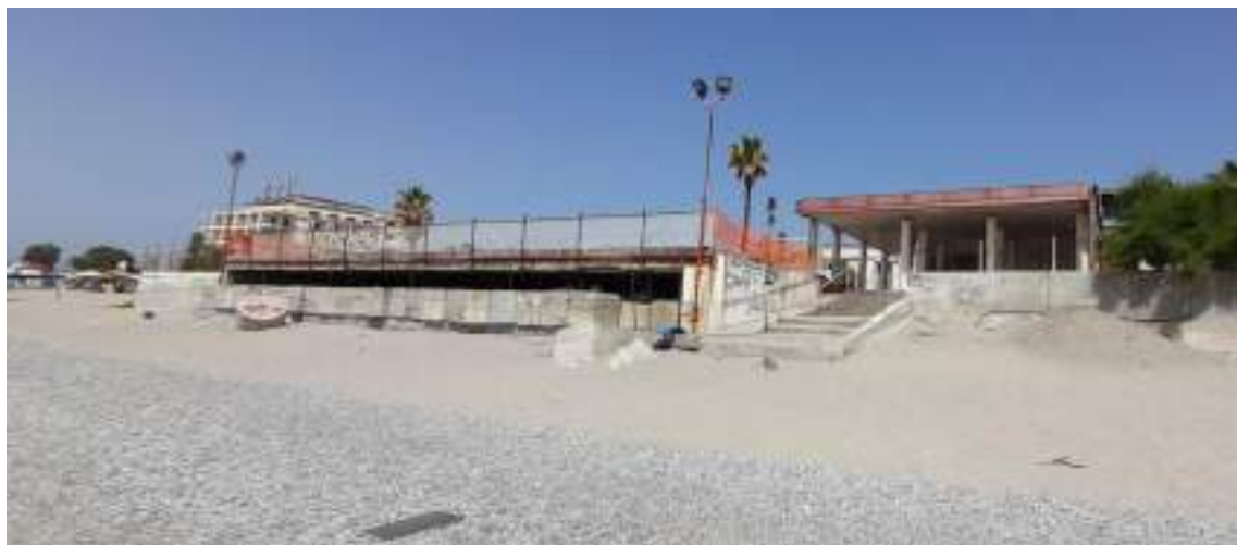
Figura 160. Una struttura abbandonata a ridosso di una spiaggia
