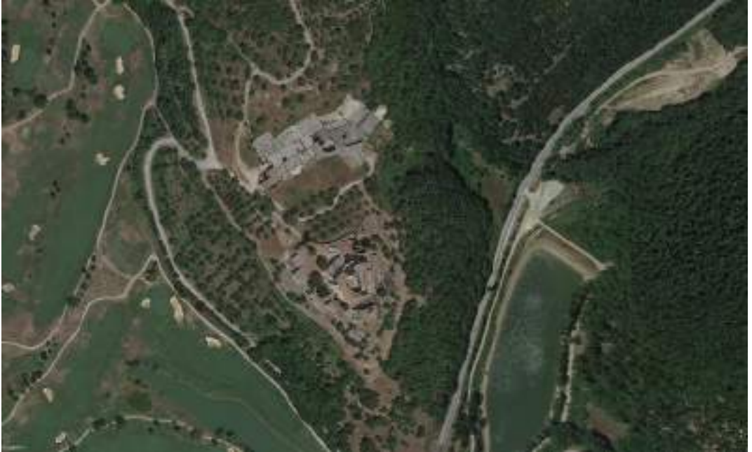
Figura 261. Borgo e Castello prima inizio lavori
