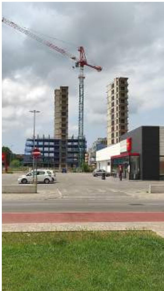
Figura 1. Edifici in costruzione nella periferia di Pisa
