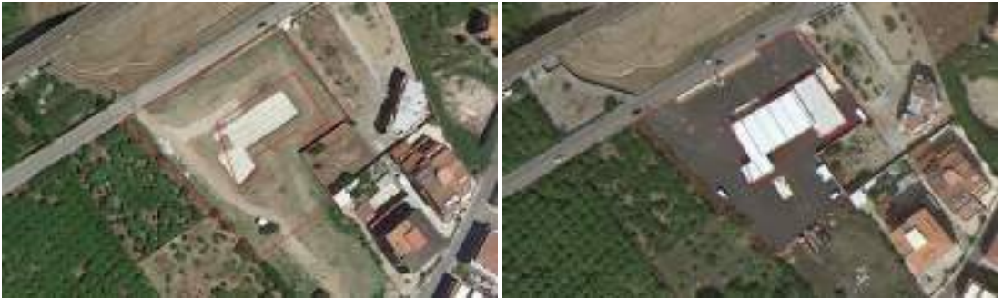
Figura 267. Comune di Barcellona Pozzo di Gotto (prov. Messina): area interessata dalla realizzazione di un impianto di distribuzione carburanti con estensione di poco meno di 0,5 ettari. Fonte: elaborazioni ARPA Sicilia su immagini Google Earth
