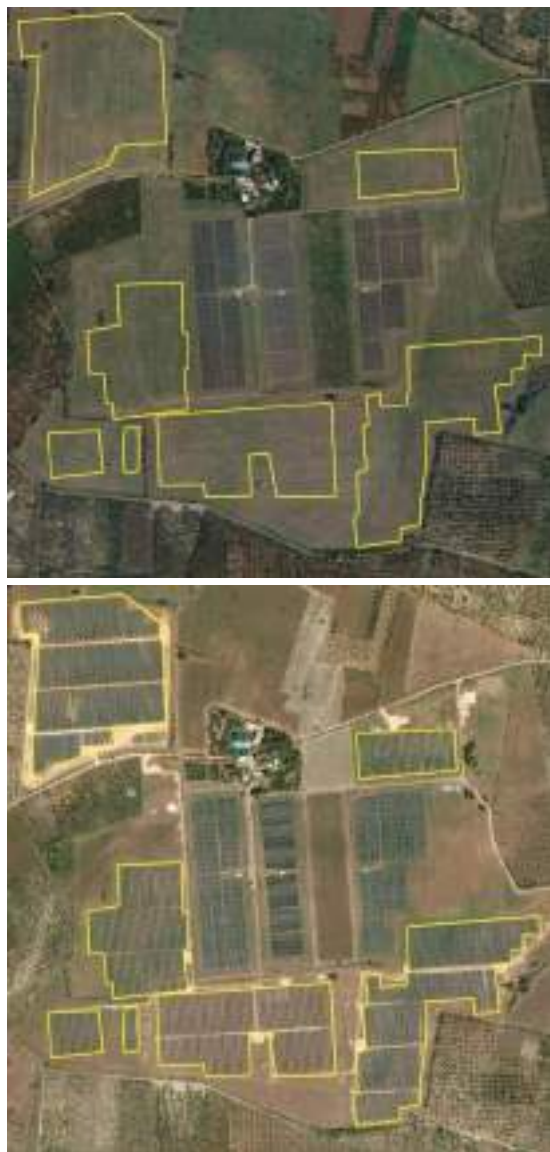
Figura 138. Installazione di impianti fotovoltaici a terra nel comune di Palo del Colle (Bari), immagini 2020 (in alto) e 2021 (in basso)
