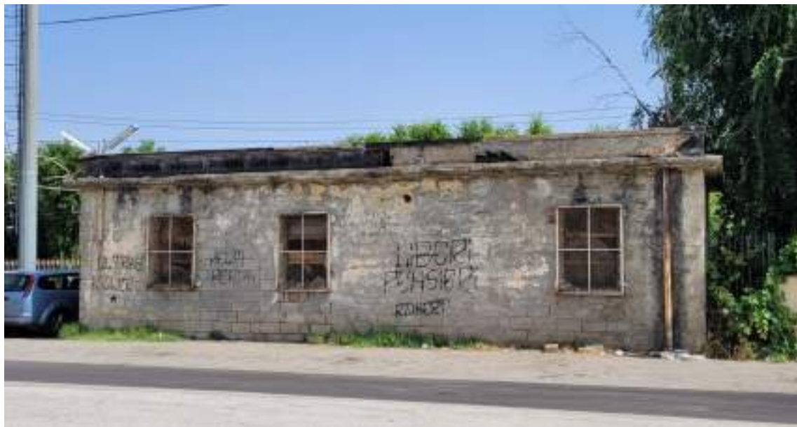
Figura 8. Un edificio abbandonato
