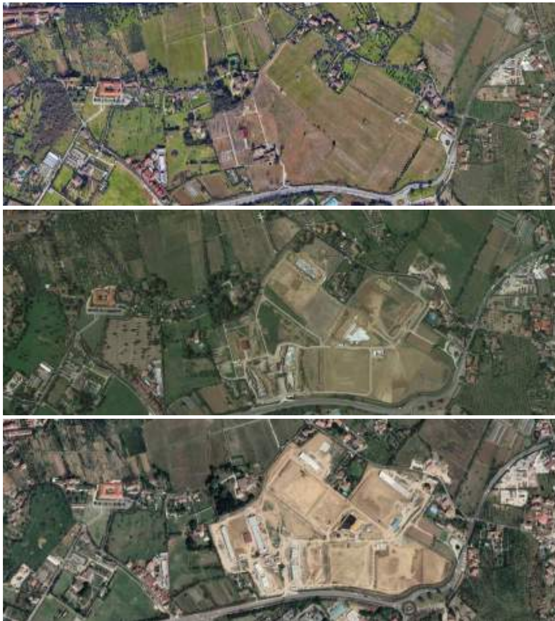
Figura 101. Area cantieristica (classe 122) di 24 ettari nel Comune di Bagno a Ripoli in provincia di Firenze immagine in alto (2020), seconda immagine (2021) e ultima immagine (2022)
