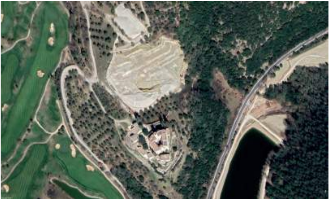
Figura 262. Borgo e Castello a cantiere avviato
